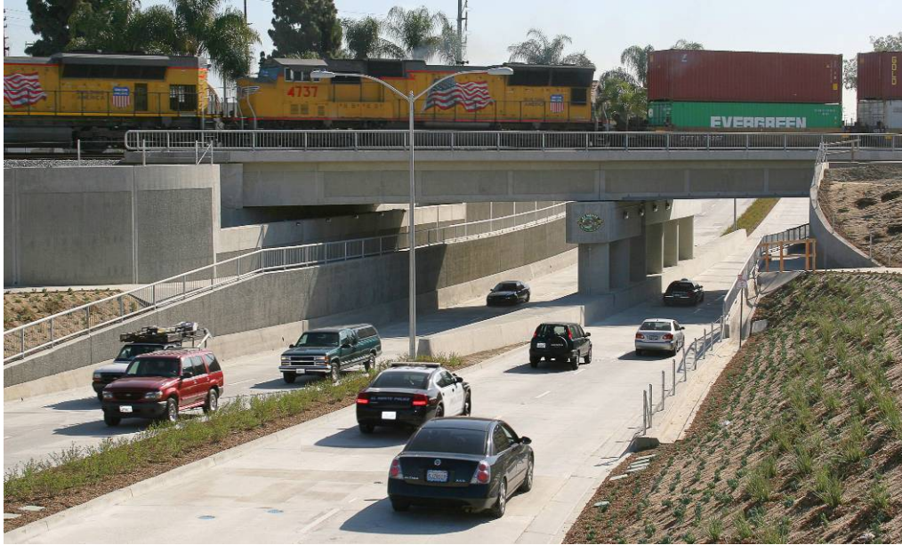
Ramona Boulevard (北向) 分隔工程完工實景。
