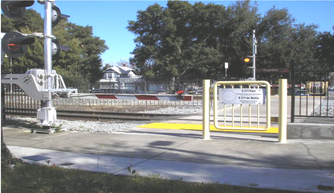
Imagen del tipo de puertas peatonales propuestas para instalación en los cruces de ferrocarril de Pomona
